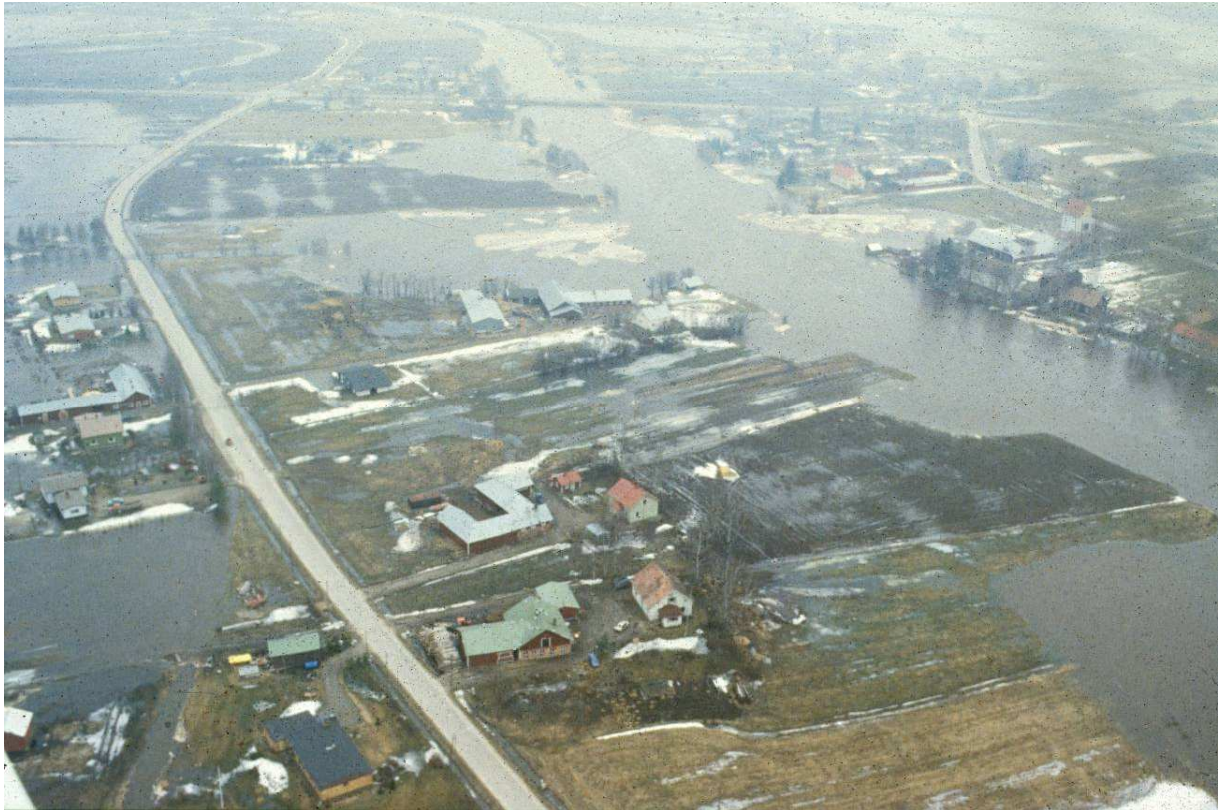
Bild 26. Översvämnningar våren 1984 i Lappeenranta ovanför Pouttu bro. (Unto Tapio)
