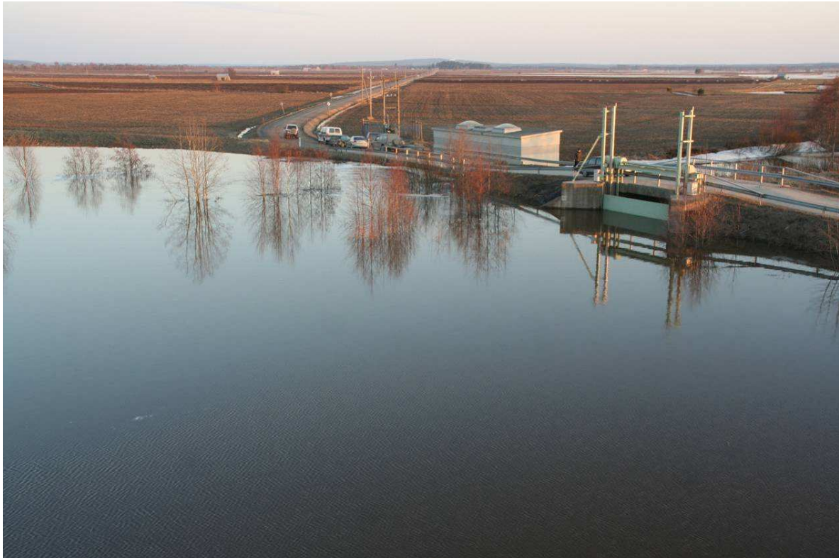
Bild 17. Pumpstationen och översvämningsluckan vid Löyhinki 12.4.2010. (Katja Haukilehto)
